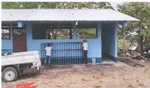
Foto 5: Fabricación e intalación de balcones
