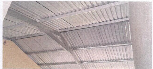
Foto 4: Sustitución de estructura de soporte de metal por metal
