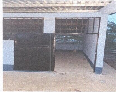
Foto 8: Sustitución de puertas de metal
