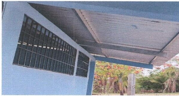
Foto 3: Sustitución de lámina troquelada aluzing
