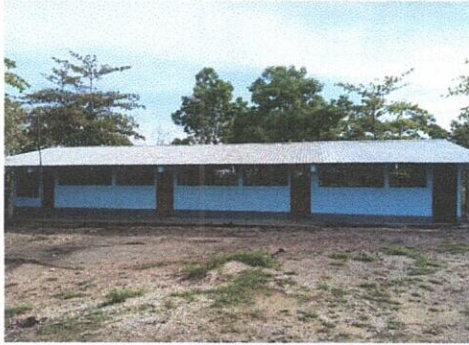
Foto1: Pintura en muros exteriores e interiores
