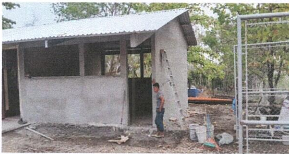
Foto 3: Sustitución de lámina troquelada aluzing
