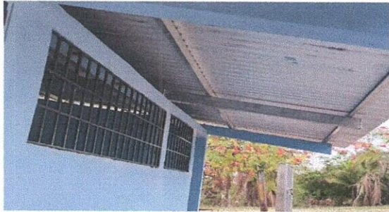
Foto 7: Mantenimiento de puertas de metal
