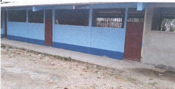
Foto 5: Fabricación e intalación de balcones
