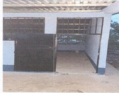
Foto 8: Sustitución de puertas de metal
