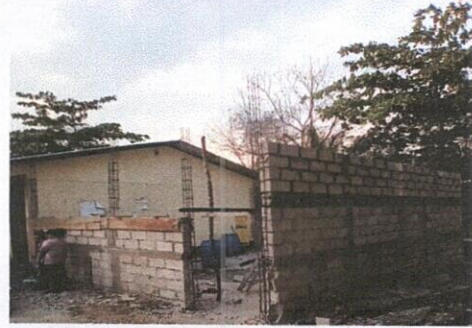
Foto 2: Reparación de muros de contención
