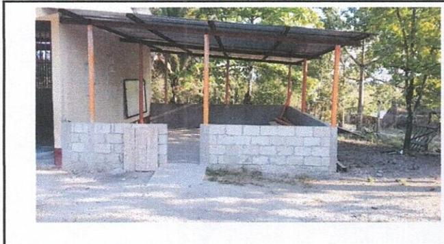
Foto 3: Sustitución de lámina troquelada aluzing
