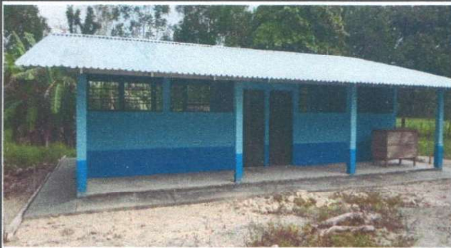
Foto 3: SUSTITUCION DE LAMINA EXISTENTE
