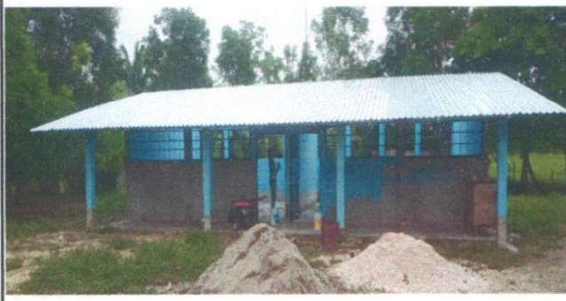
Foto 1: PINTURA EN MUROS INTERIORES Y EXTERIORES
