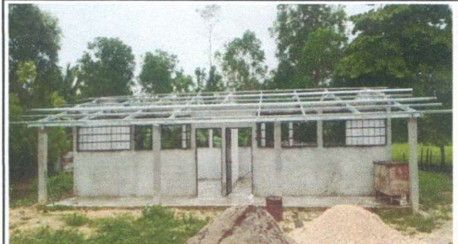
Foto 4: SUSTITUCION DE ESTRUCTURA PORTANTE, MADERA POR METAL
