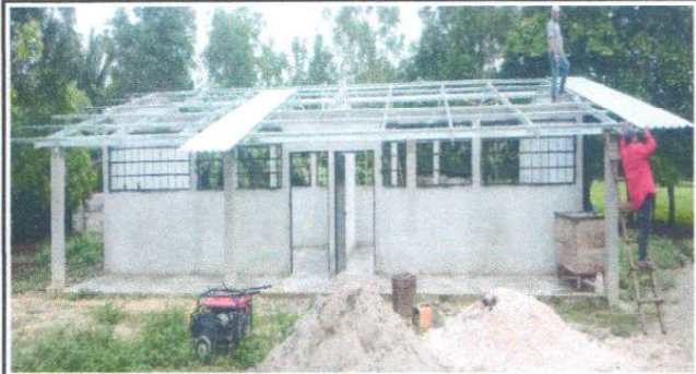
Foto 3: SUSTITUCION DE LAMINA EXISTENTE
