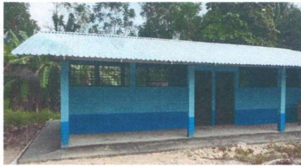
Foto1: PINTURA EN MUROS INTERIORES Y EXTERIORES
