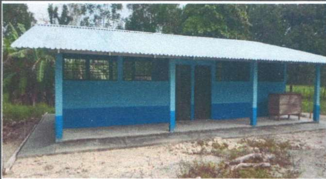
Foto 3: SUSTITUCION DE LAMINA EXISTENTE
