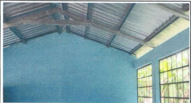
Foto 4: SUSTITUCION DE ESTRUCTURA PORTANTE, MADERA POR METAL
