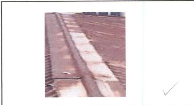
Foto7: Sustitucion de capote de lamina para lamina troquelada
