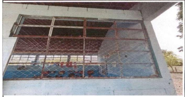
Foto 2: 5.2 Sustitucion de estructura de metal de ventana.
