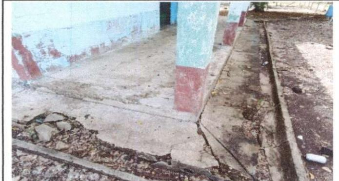
Foto 3: 8.2 Sustitucion de piso de concreto
