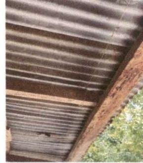
Foto 2: Sustitucion de lamina, por lamina troquelada aluzinic calibre 26
