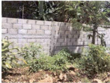
Foto 3: APLICACIÓN DE REPELLO DE MURO DE CONTENCIÓN
