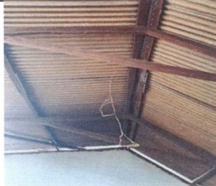
Foto 2: INSTALACIÓN DE UNIDAD DE LUZ
