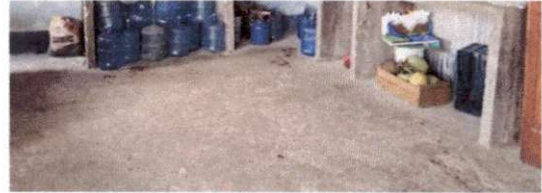
Foto 2: SUSTITUCIÓN DE PISO CERAMICO
