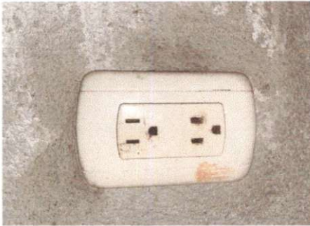
Foto 3: SUSTITUCIÓN DE TOMACORRIENTES DOBLES
