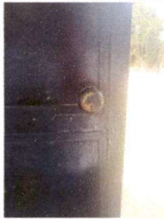
Foto 1: SUSTITUCIÓN DE CHAPA
