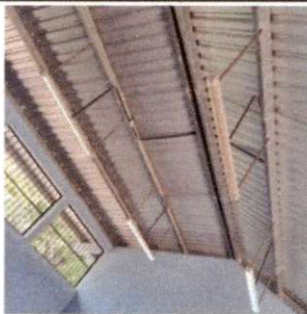
Foto 5: SUSTITUCIÓN DE LAMPARAS TIPO LED
