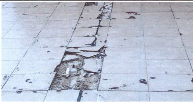
Foto 5: Sustitución de piso ceramico
