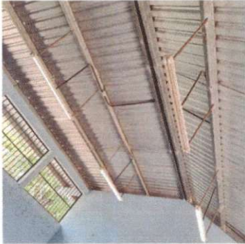
Foto 1: SUSTITUCIÓN DE FOCOS AHORRADORES
