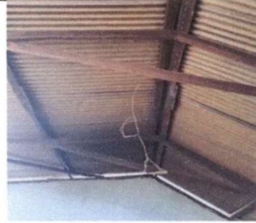
Foto 2: INSTALACIÓN DE UNIDAD DE LUZ
