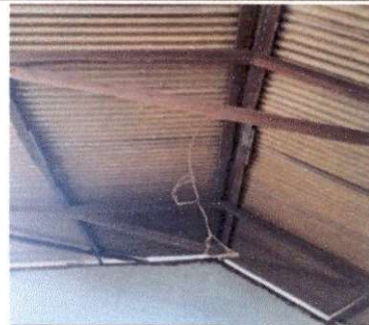
Foto 4: REPARACIÓN DE CABLEADO ELECTRICO
