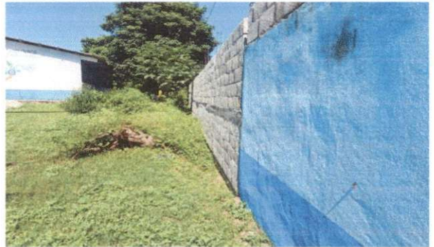
Foto 4: Repello en muro
