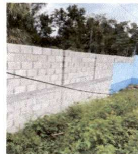
Foto 6: PINTURA EN MUROS EXTERIORES E INTERIORES
