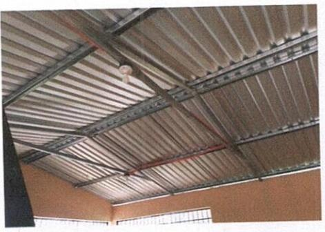
Foto 3: Sustitución de lámina, por lámina troquelada aluzinc calibre 26 y sustitución de soporte de madera por metal.
