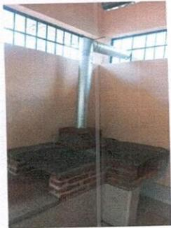
Foto 2: Sustitución de estufa rural (completa)
