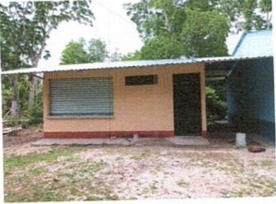
Foto1: Sustitución de puerta de madera por una de metal y sustitucion de malla de ventanas por ventanas y balcones de metal .
