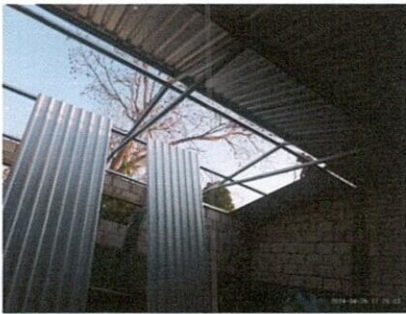
Foto 3: Sustrucción de lámina, por lámina troquelada aluzinc calibre 26 y sustitución de soporte de madera por metal.
