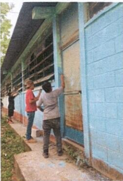
Foto 5: Pintura en muros exteriores
