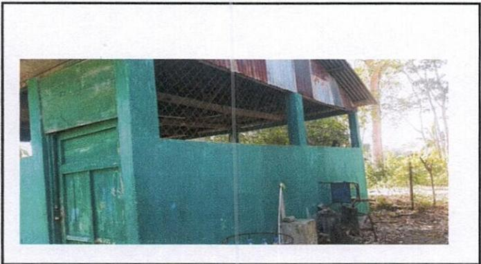
Foto 3: Sustitución de lámina, por lámina troquelada aluzinc calibre 26 y sustitución de soporte de madera por metal.
