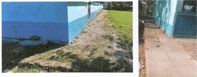
Foto 7 : Reparacion de banqueta de concreto
