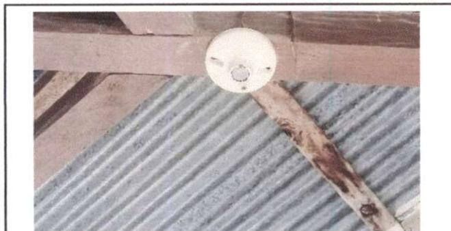
Foto 5: SUSTITUCIÓN DE PLAFONERAS
