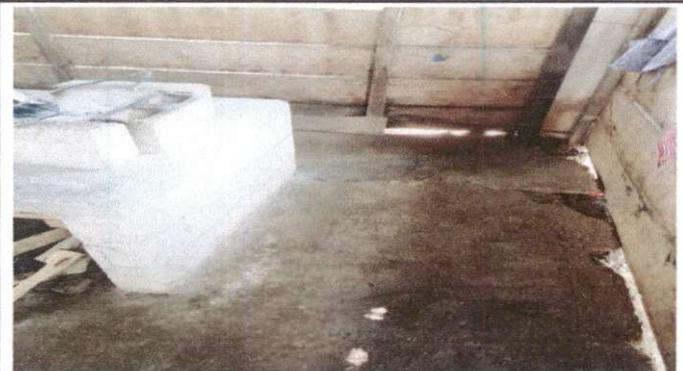
Foto 9: Sustrición de Piso De Torta De Concreto ✓
