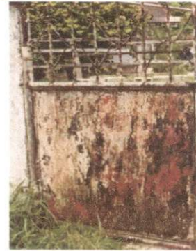
Foto 4: Fabricación instalación de porton de metal de ingreso 1.5mx2m
