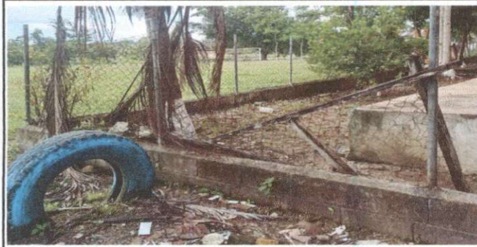
Foto 1: Reparación de Muro Perimental de Block con tubo hg y malla galvanizada soleras intermedias.
