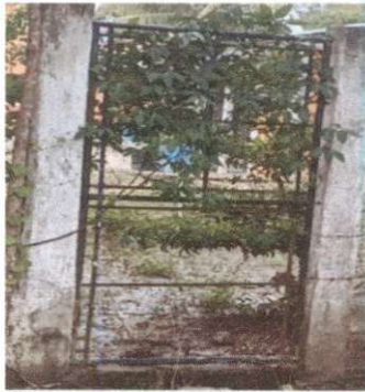
Foto 5: Fabricación instalación de porton de metal de ingreso 1mx2m
