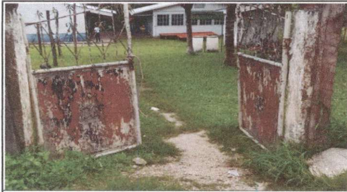
Foto 3: Fabricación instalación de porton de metal de ingreso 2.8mx2m
