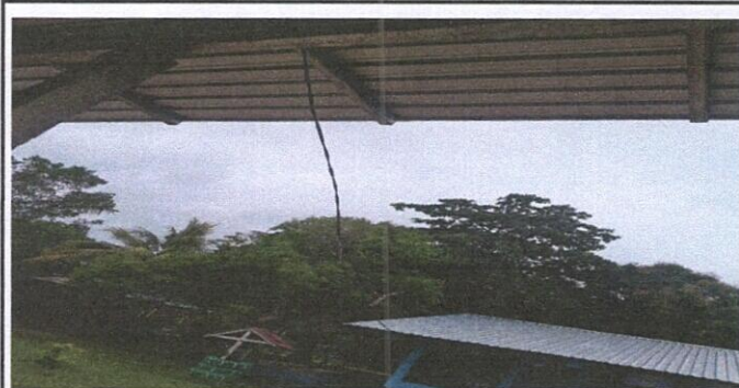
SUSTITUCIÓN DEL CABLEADO PRINCIPAL
