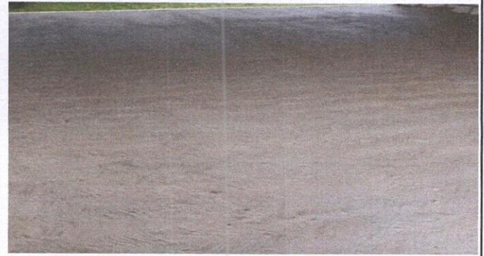
SUSTITUCIÓN DE TORTA DE CEMENTO
