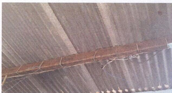
SUSTITUCIÓN DEL CABLEADO PRINCIPAL
