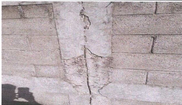
REPARACIÓN EN MURO DE CONTENCIÓN
