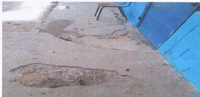
SUSTITUCIÓN DE TORTA DE CEMENTO
