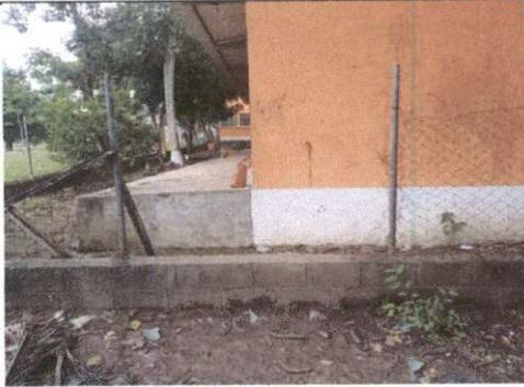
Foto 1: Sustrucción de muro perimetral de block y malla galvanizada
