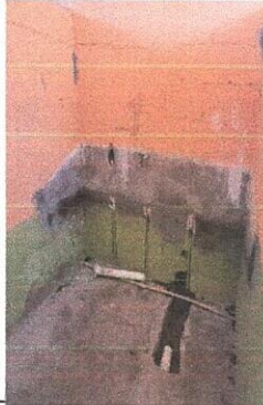
Foto 7: Sustitución de inodoros
