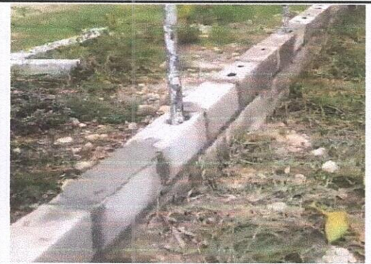
Foto 10: Reparación de muro perimetral de block
