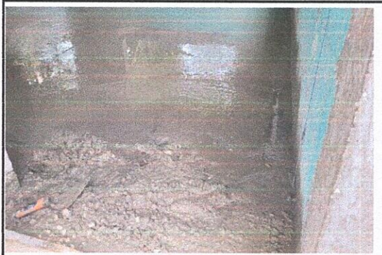
Foto 15: Sustitución de piso de torta de concreto
