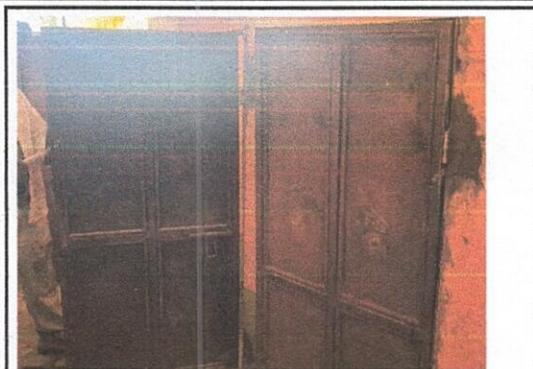
Foto 14: Mantenimiento a estructura a puertas sanitarios (lijado, cambio de tubo , cepillado, sujeciones, aplicación de pintura)
