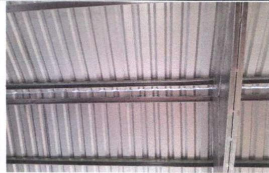
Foto 2: 1.2 Sustitucion de capote de lamina para lamina troquelada.
