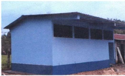
Foto 1: 1.1 Sustitucion de lamina troquelada aluzinc calibre 26.
