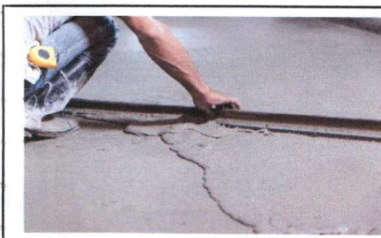
Foto 6: 8.2 Sustitucion de piso de concreto
