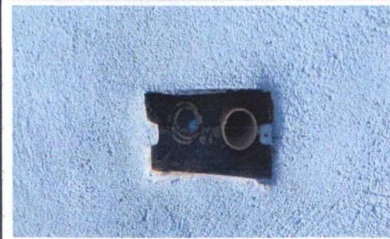
Foto 8: 17.12 Sustitucion de ducto electrico + accesorios
