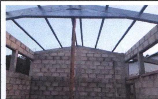
Foto 3: 2.2 Sustitucion de estructura de soporte de madera por metal
