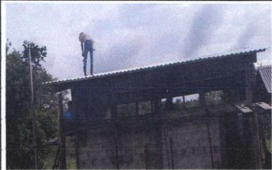
Foto1: 1.1 Sustitución de lamina troquelada aluzinc calibre 26.
