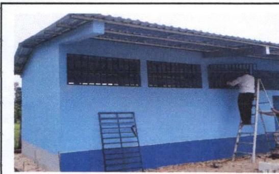
Foto 5: 5.3 Sustitucion de ventana de madera por metal mas vidrio
