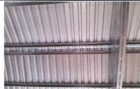
Foto 2: 1.2 Sustitución de capote de lamina para lamina troquelada.
