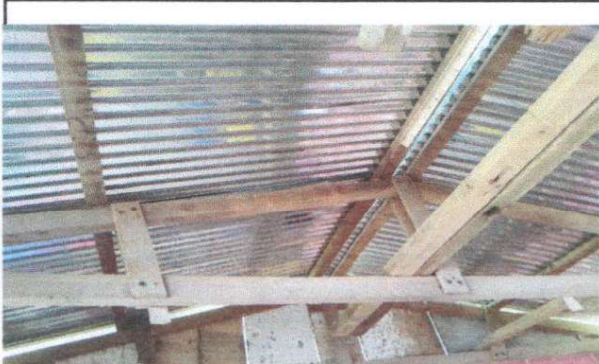
Foto 1: 1.1 Sustitución de lamina troquelada aluzinc calibre 26.
