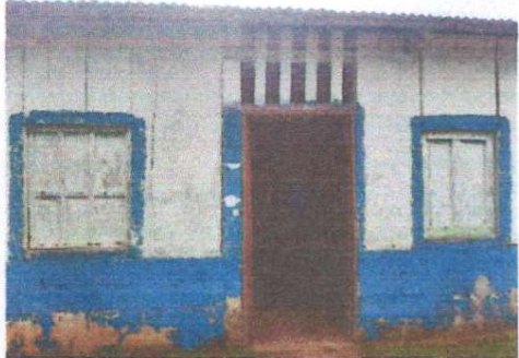
Foto 7: 9.1 Pintura en muros exteriores e interiores.
