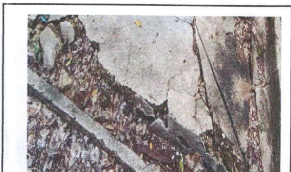
Foto 6: 8.2 Sustitución de piso de concreto
