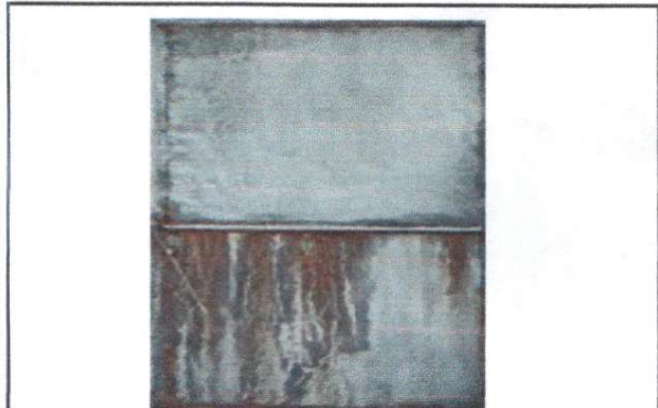
Foto 4: 4.3 Sustitución de puerta.
