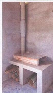
Foto 4: sustitución de estufa rural completa, incluye chimenea y planch de metal
