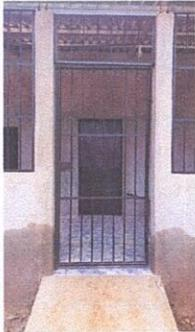
Foto 5: sustitución de puerta y balcones de metal, reparación de cableado electrico, sustitución de ducto mas accesorios, sustitución de flipones.
