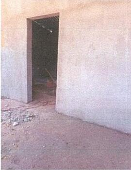
Foto1: Reparación de muro, Repello en muro
