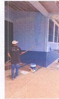
Foto 6: Pintura en muros exteriores e interiores. Sustitución de plafoneras, sustitución de focos ahorradores y sustitución de tomacorrientes dobles
