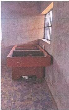
Foto 3: Sustitución de pila de cemento de dos lavaderos. Sustitución de tubería línea principal, sustitución de llave de chorro.
