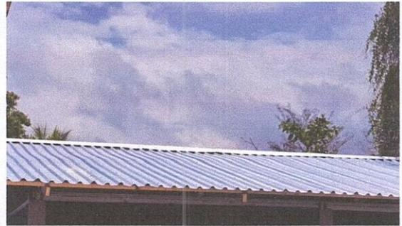
Foto 2: Sustitución de lámina, por lámina troqueladaaluzinc calibre 26, sustitución de estructura de soporte de madera por metal, sustitución de capote
