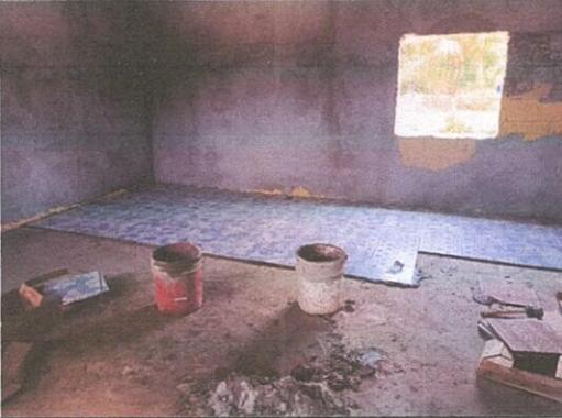
Foto 7: Reparación de piso de concreto, Sustitución de piso ceramico
