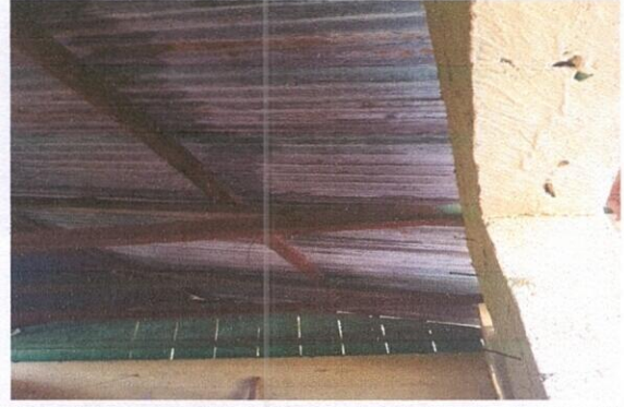
Foto 2: Sustitución de lámina, por lamina troquelada aluzinc calibre 26, sustitución de estructura de soporte de madera por metal, sustitución de elementos de fijación, sustitución de capaote de lámina para lamina
