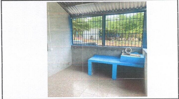
Foto 2: Finalización de colocación de estufa rural
