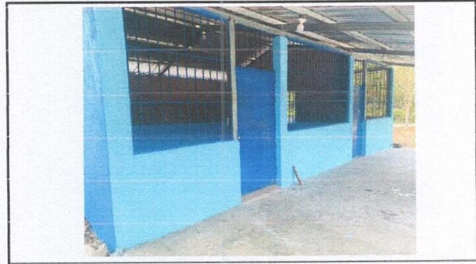
Foto 4: Finalización de instalación de puerta
