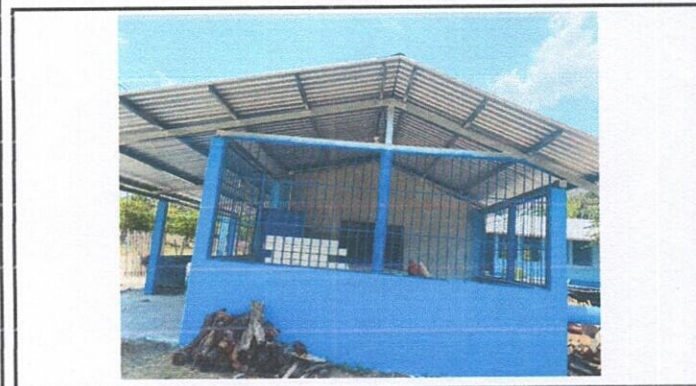
Foto 3: Finalización de balcones
