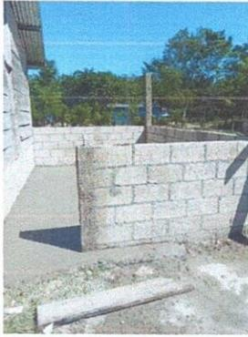
Foto1: Sustrucción de piso de torta de concreto
