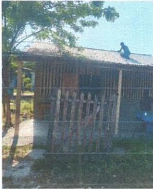
Foto 1: Sustitución de lamina por lámina troquelada
