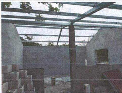
Foto 3: Instalación de estructura portante de metal
