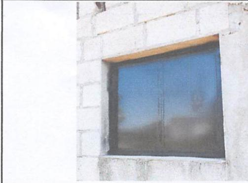
Foto 1: Sustrucción de ventana de madera por ventana de metal
