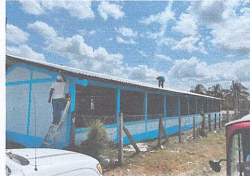
Foto 2: Sustitución de lámina troquelada aluzinc calibre 26
