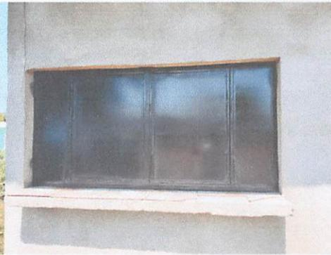
Foto 3: Sustrucción de ventana de madera por ventana de metal
