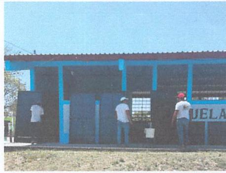
Foto 6: Sustitución de puerta de metal
