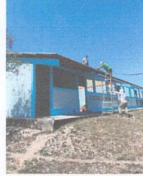
Foto 2: Sustitución de lámina troquelada aluzinc calibre 26
