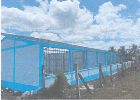
Foto1: Sustitución de capotes de lámina para lámina troquelada
