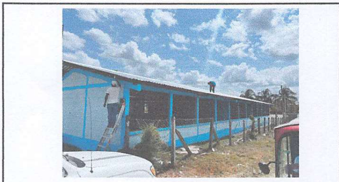
Foto 2: Sustitución de lámina troquelada aluzinc calibre 26
