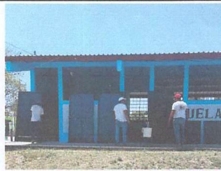
Foto 6: Sustitución de puerta de metal
