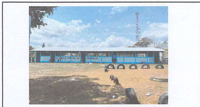
Foto 3: Sustitución de lámina troquelada aluzinc calibre 26
