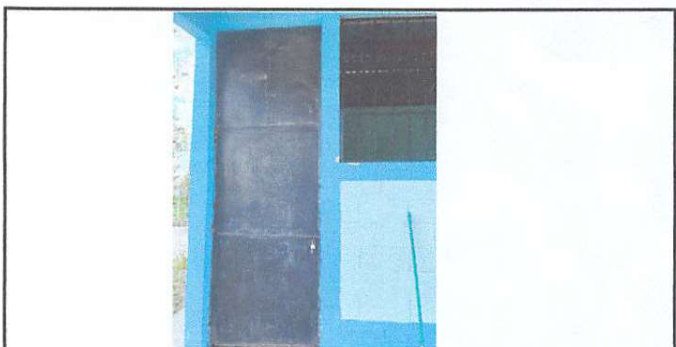
Foto 6: Sustitución de puerta de metal
