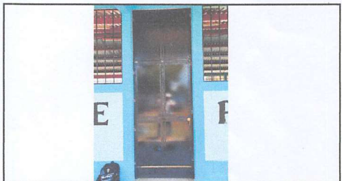
Foto 6: Sustitución de puerta de metal
