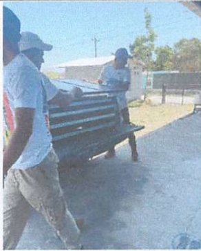
Foto1: Sustitución de ventana de madera por ventana de metal
