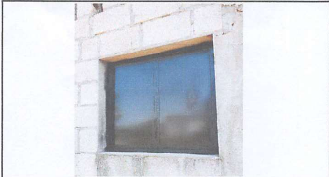
Foto1: Sustitución de ventana de madera por ventana de metal
