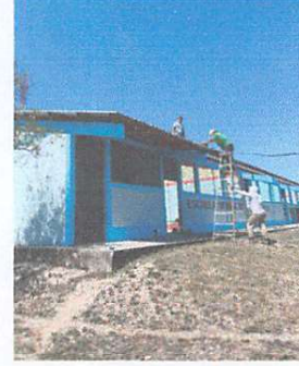
Foto 2: Sustrucción de lámina troquelada aluzinc calibre 26
