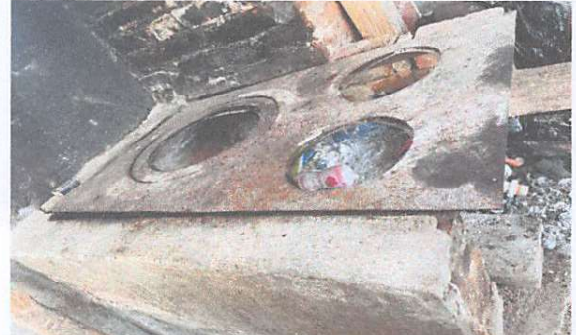
Foto 6: Sustitución de plancha de metal de tres hornillas
