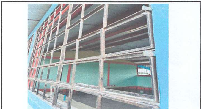
Foto 4: Mantenimiento de balcones de metal
