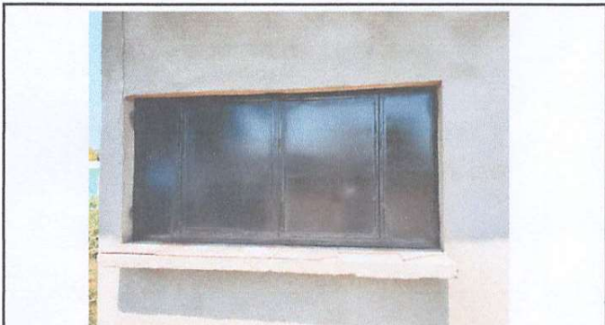
Foto 3: Sustitución de ventana de madera por ventana de metal
