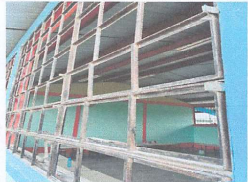
Foto 4: Sustitución de Balcones de metal
