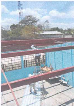
Foto 3: Mantenimiento a estructura a soporte de Metal
