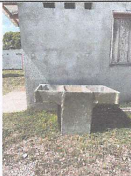
Foto 5: Sustrucción de pila de cemento de dos lavaderos
