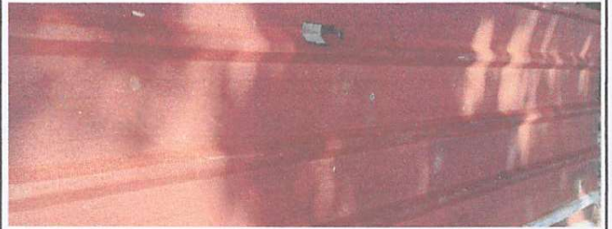
Foto 2: Sustitución de lámina, por lámina troquelada alizinc calibre 26
