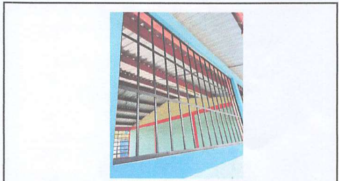
Foto 4: Mantenimiento de balcones de metal
