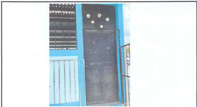
Foto 2: Mantenimiento de puerta de metal
