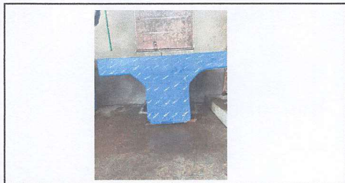
Foto 5: Sustición de pila de cemento de dos lavaderos
