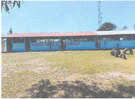
Foto1: Sustitución de capotes de lámina para lámina troquelada
