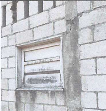
Foto 3: Sustitución de ventana de madera por ventana de metal
