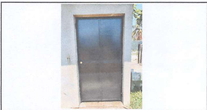
Foto 5: Sustitución de puerta de madera por puerta de metal
