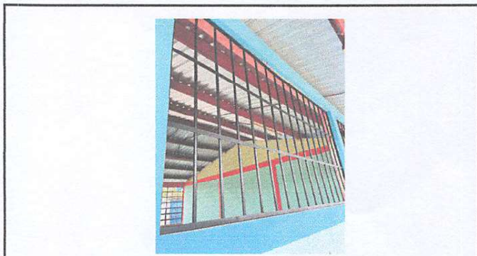
Foto 4: Sustitución de balcones de metal
