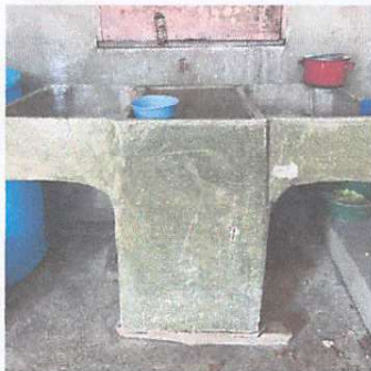
Foto 5: Sustitución de pila de cemento de dos lavaderos
