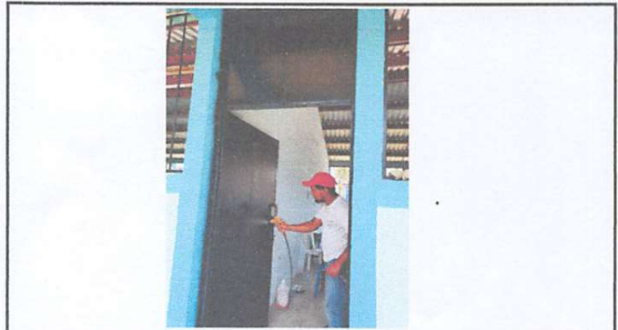
Foto 2: Mantenimiento de puerta de metal
