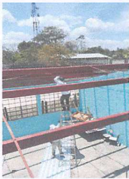
Foto 3: Mantenimiento estructura de metal
