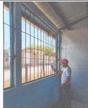
Foto 4: Mantenimiento de balcones de metal
