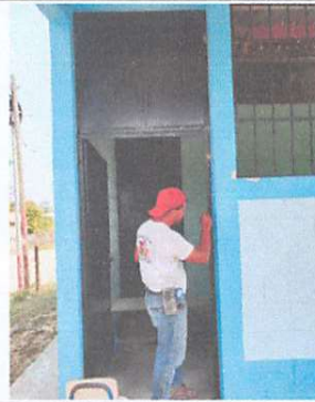
Foto 2: Mantenimiento de puerta de metal
