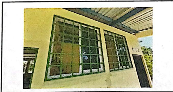
Foto 5: Sustitución de ventana de metal por vidrio
