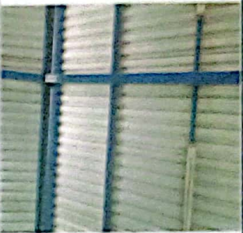
Foto 1: Sustracción de lamina, por lamina troquelada Aluzinc calibre 26
