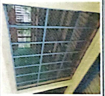
Foto 2: Mantenimiento de balcon de metal y pintura para balcon.
