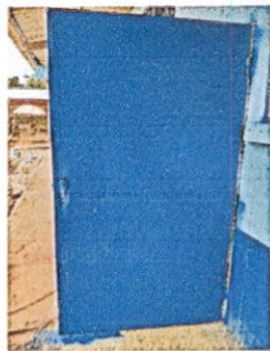
Foto 3: Mantenimiento a Estructura de Puertas
