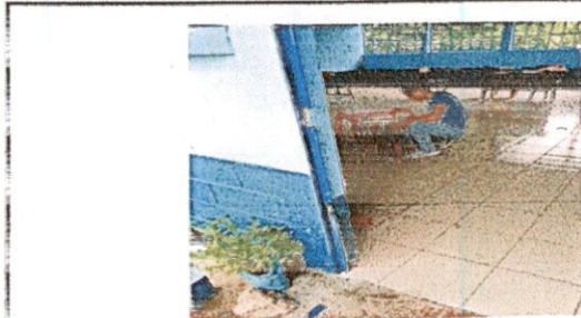
Foto 1: Sustitución de piso cerámico
