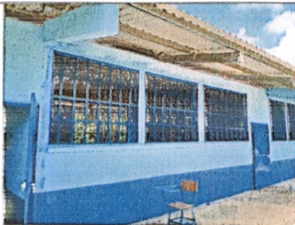
Foto 5: Mantenimiento a estructura de balcones
