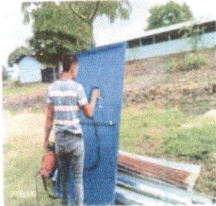
Foto 3: Mantenimiento a Estructura de Puertas
