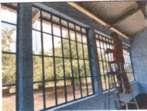
Foto 5: Mantenimiento a estructura de balcones
