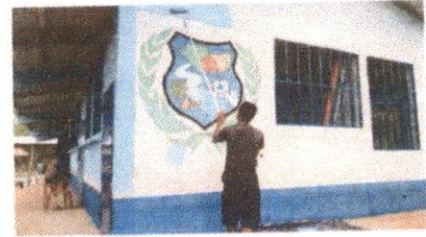
Foto 2: pintura en muros interior y exterior
