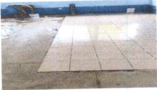
Foto1: Sustitucion de piso ceramico
