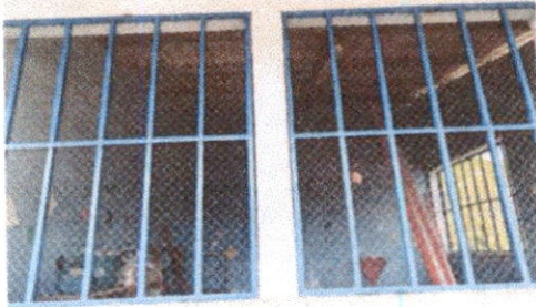
Foto 5: Mantenimiento a estructura de balcones
