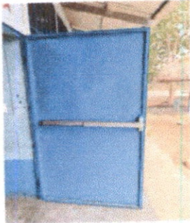
Foto 3: Mantenimiento a Estructura de Puertas
