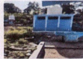
Foto 14. Sustitución de deposito de agua
