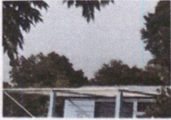
Foto 1: Sustrucción de estructura de soporte de metal
