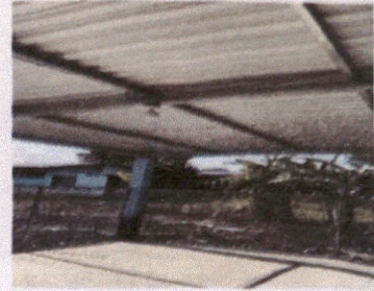
Foto 2: Sustrucción de lamina troquelada aluzunic calibre 26
