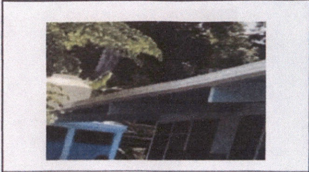
Foto 10. Sustrucción de cana de metal
