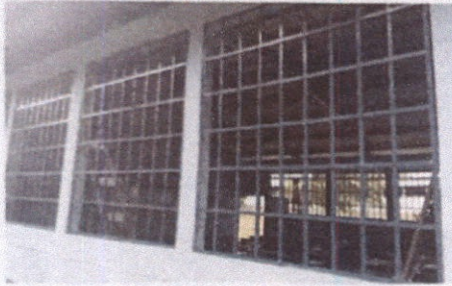
Foto 3: Mantenimiento a estructura de balcones
