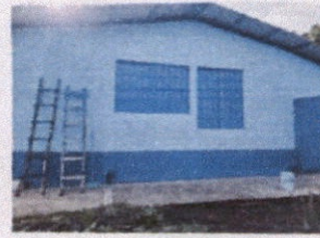
Foto 4: Pintura en muros interiores y exteriores
