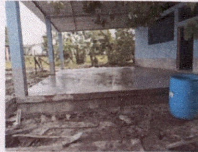
Foto 16. Reparación de piso de torta de concreto
