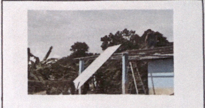
Foto 2: Sustrucion de lámina troquelada de aluzinic calibre 26
