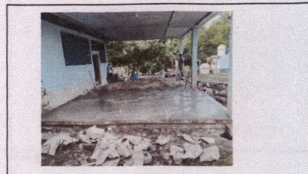
Foto 16. Reparación de piso de Torta de concreto
