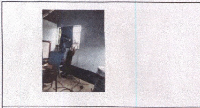
Foto 5: Sustrucion de ventana de madera por metal
