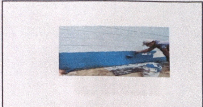
Foto 4: Pintura en muros interior y exterior
