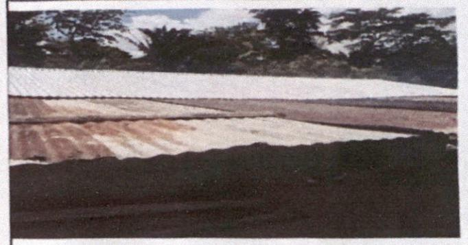
Foto 2: Sustitución de lámina por láminas troquelada de aluzinc calibre 26
