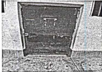
SUSTITUCIÓN DE PUERTA
