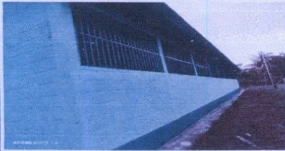
Renglón 7 pinturas en muros exteriores
