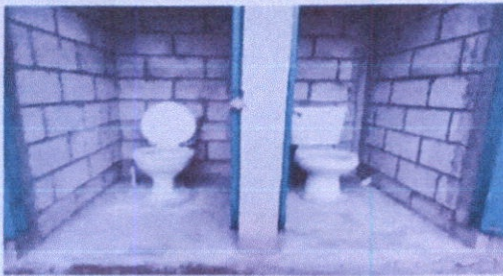
Renglón 5 Sustitución de inodoro
