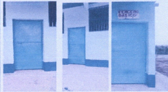
Renglón 2 Sustitución de puertas de metal
