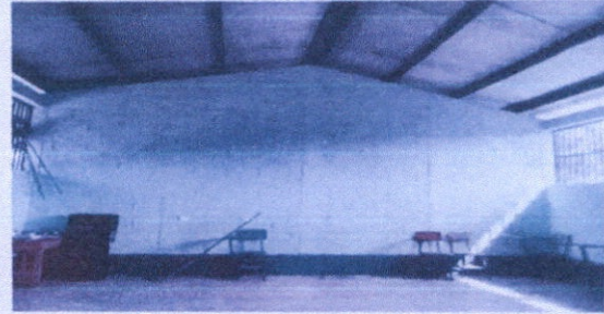
Renglón 7 Pintura en muros interiores
