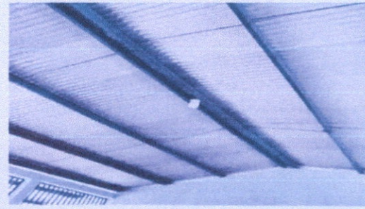
Renglón 4 Reparación de cableado eléctrico
