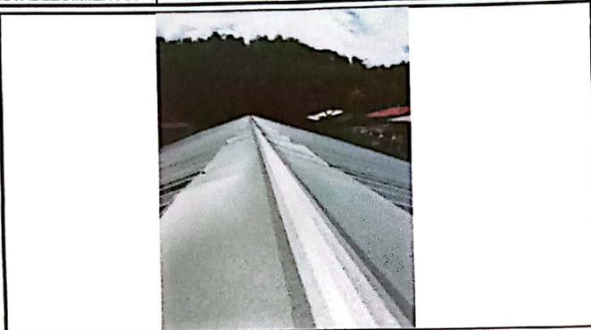
Foto1: Region. 1.1 Sustitución de lámina por lámina troquelada aluzinc calibre 26
