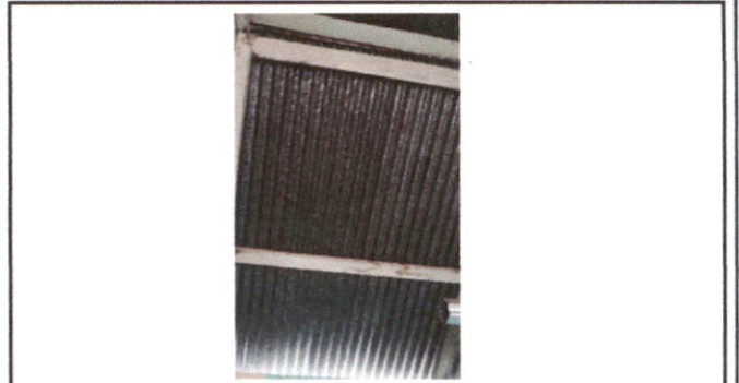
Foto 4: Renglon 7 Sustitución de láminas
