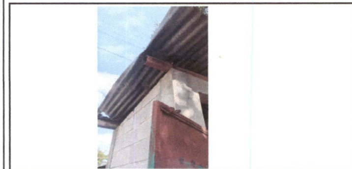
Foto 5: Renglon 7 Sustitución láminas
