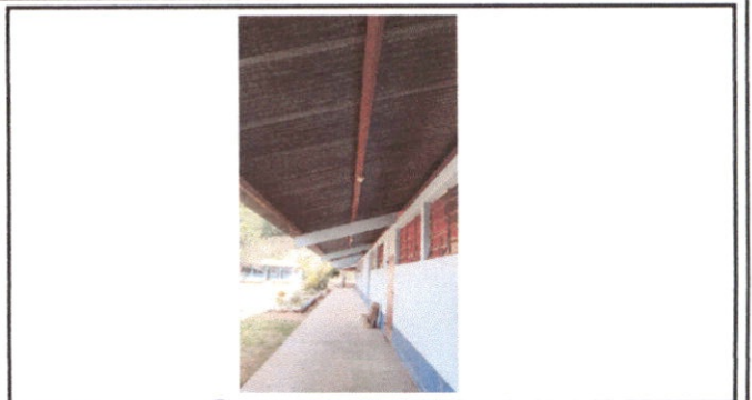
Foto 2: Renglon 77 Reparación de sistema Eléctrico
