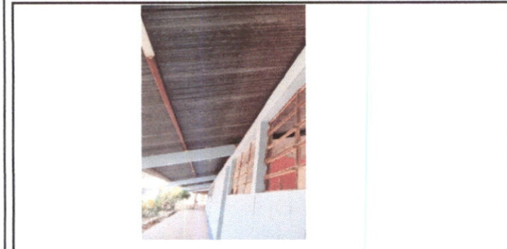
Foto 3: Renglon 01 Sustitución de láminas.
