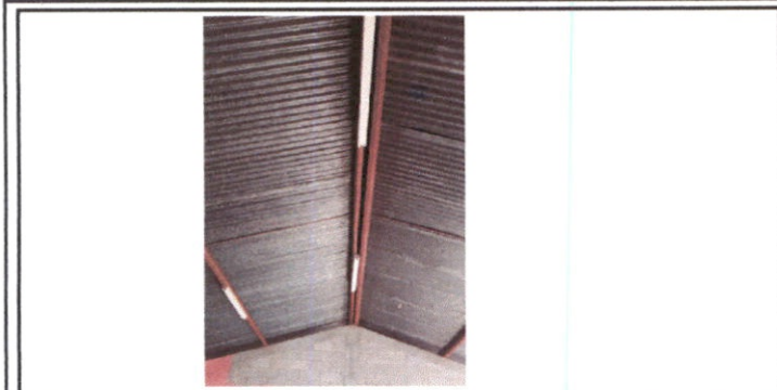
Foto 1: Renglon 01 Sustitución de láminas
