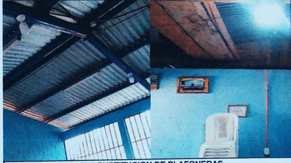
Foto 2: RENGLO 17.5 SUSTITUCION DE PLAFONERAS
