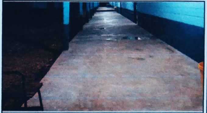
Foto 2: RENGLON 6 REPARACION DE PISO DE TORTA DE CONCRETO
