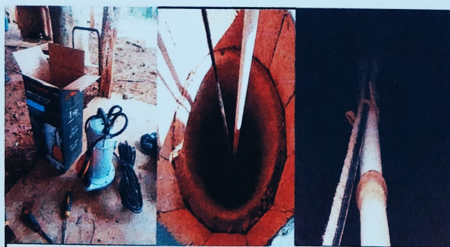
Foto 5: RENGLON 18 SUSTITUCION DE BOMBA DE AGUA
