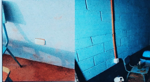
Foto 4: RENGLO 17. 8 SUSTITUCION DE TOMACORRIENTES DOBLES
