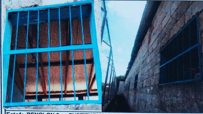
Foto 1: RENGLON 5 SUSTITUCION DE BALCONES DE METAL
