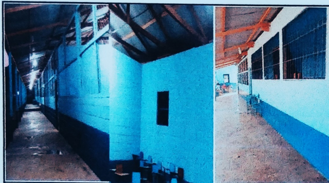
Foto 3: RENGLON 9 PINTURA EN MUROS EXTERIORES E INTERIORES
