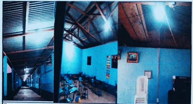
Foto 4: RENGLON 17 REPARACION DE CABLEADO ELECTRICO
