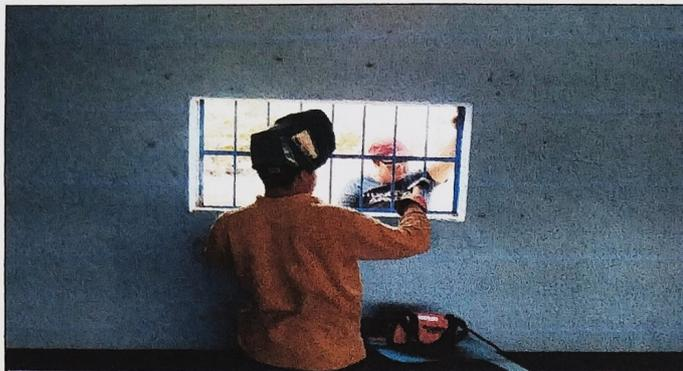
Foto1: RENGLON 5 SUSTITUCION DE BALCONES DE METAL
