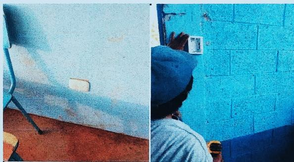
Foto 4: RENGLON 17. 8 SUSTITUCION DE TOMACORRIENTES DOBLES
