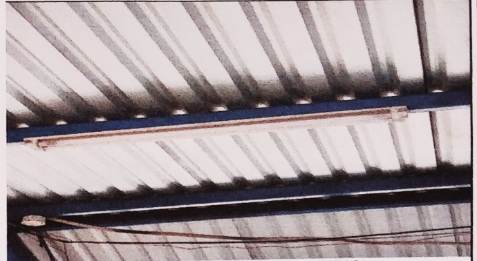
Foto 2: RENGLON 17.5 SUSTITUCION DE PLAFONERAS
