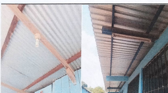
Foto 4: RENGLON 17 REPARACION DE CABLEADO ELECTRICO
