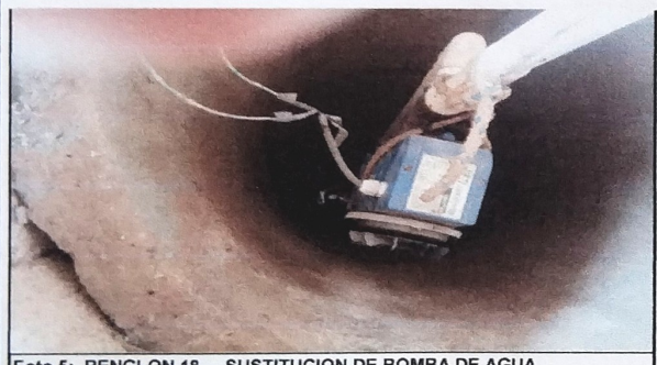
Foto 5: RENGLON 18 SUSTITUCION DE BOMBA DE AGUA
