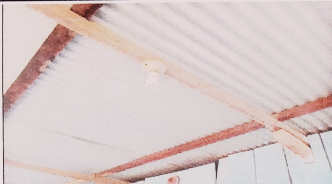
Foto1: RENGLON 17.4 SUSTITUCION DE FOCOS AHORRADORES
