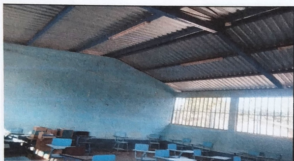
Foto 3: RENGLON 9 PINTURA EN MUROS EXTERIORES E INTERIORES
