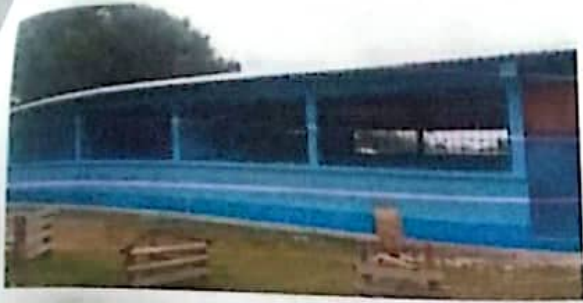
Foto 1: Sustitucion de lamina por lamina troquelada
