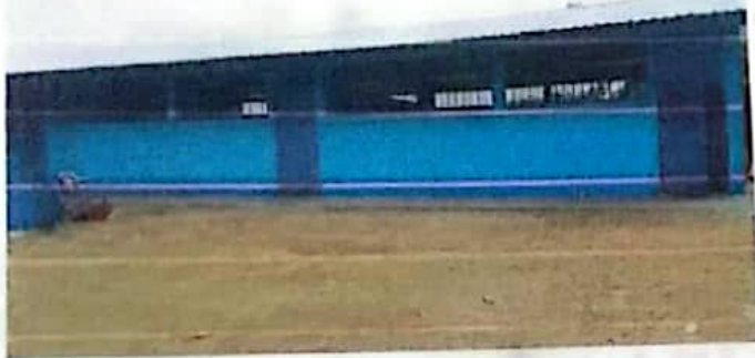
Foto 3: Mantenimiento de soporte de estructura de metal
