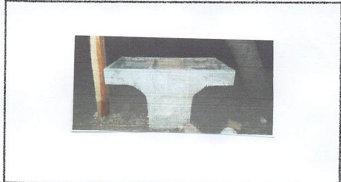
Foto 2: Sustitución de Pila
