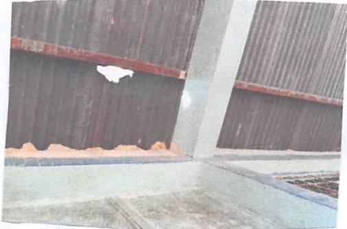
Foto 1: Cambio de lamina galvanizada
