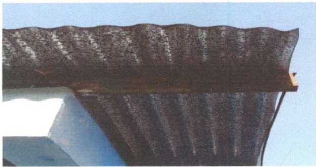
Foto 3: sustición de estructura de soporte de metal por metal
